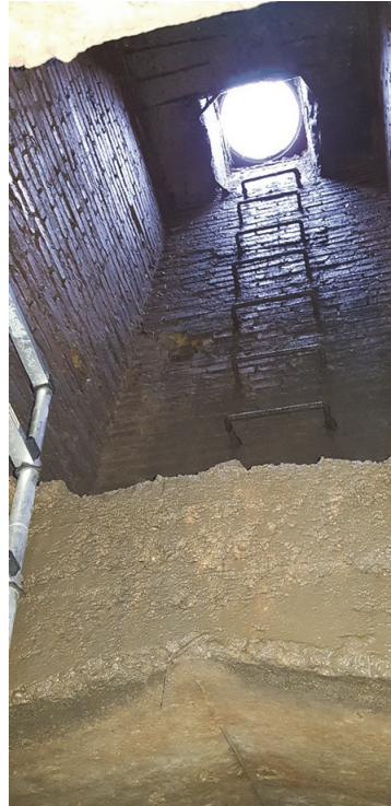
Vistes del tercer tram de la galeria i del pou d'accés 2
