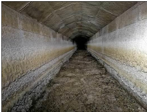
Tram de galeria on es pot intuir les diferents marques de nivell de l'aigua. S'observa la paret plena de crustacis tipus Gla de mar. (Balanus)
