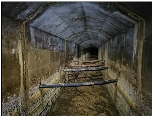
Tirants estructurals i cablejat elèctric carrer Vilà i Vilà.
