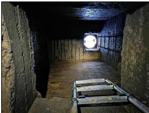
Vista pou 2 des de l'interior de la galeria.
