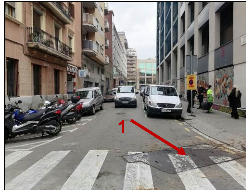
Registre pou 1 carrer Vilà i Vila amb carrer Cabanes
