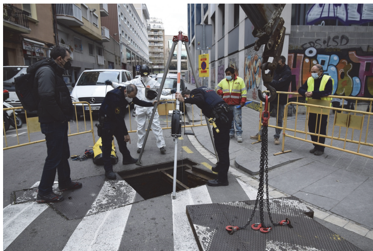
Vista dels treballs d'inspecció de la galeria
