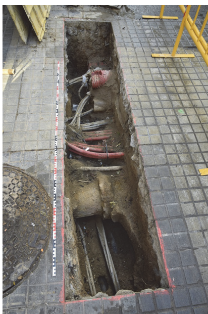
Exemples de cales realitzades en les zones de vorera
