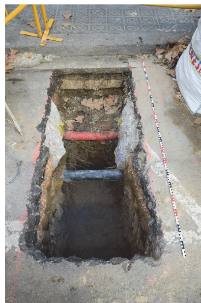
Exemples de cales realitzades en calçada
