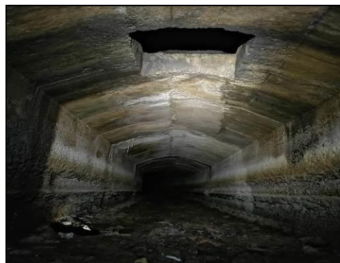
Vista interior Pou 3 avinguda Paral·lel.
